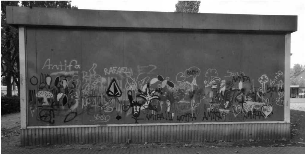
Abb. 3: Rückseite des Pavillons
