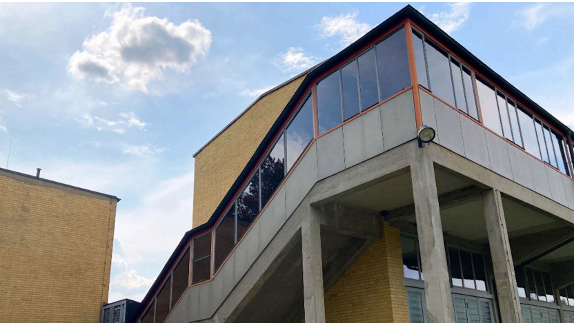
Abb. 7: Laubengang oberhalb der Turnhalle mit Zugang zu den darüber liegenden Seminarräumen (Foto: Wendeburg 2021)
