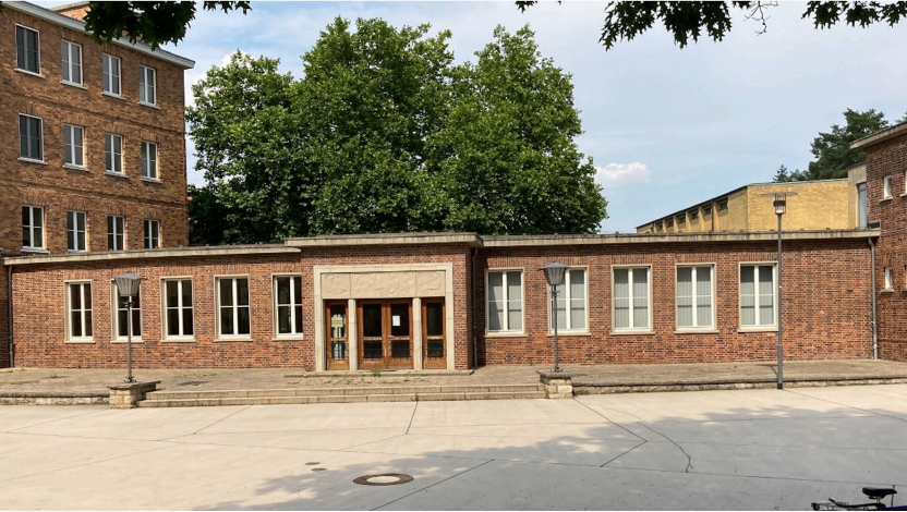
Abb. 10: Waterstradt'scher Verbindungsgang (Foto: Wendeburg 2021)
