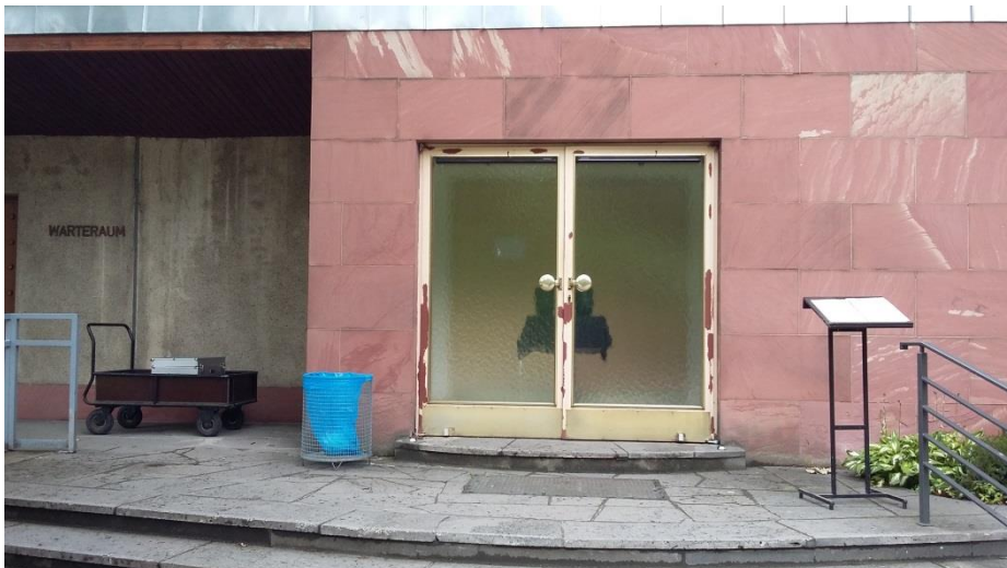
Abbildung 1: Eingang zur Feierhalle, Parkfriedhof Neukölln (Foto: F.S.)
