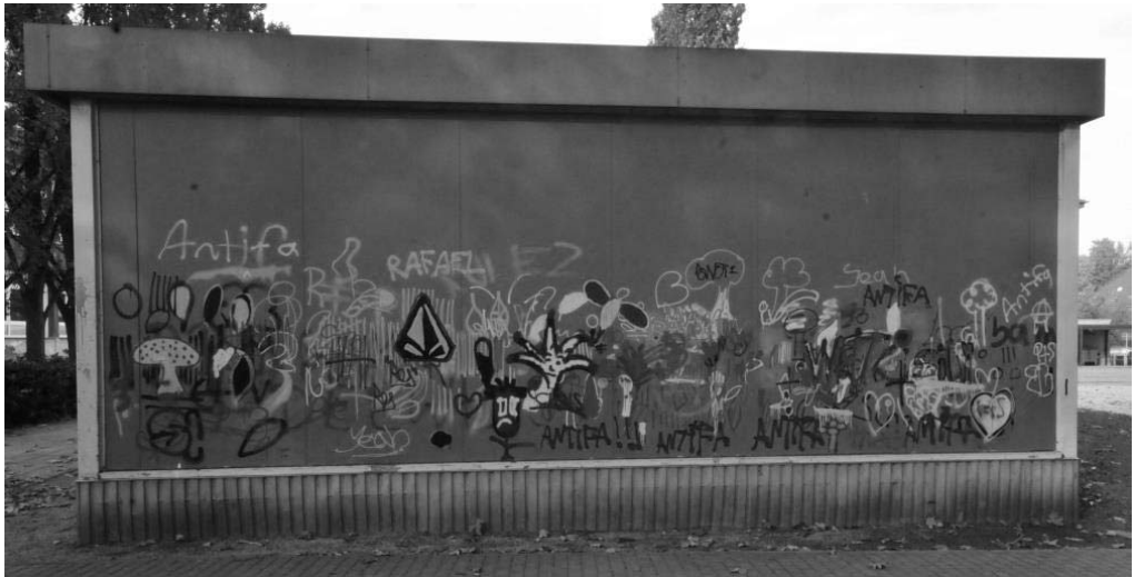
Abb. 3: Rückseite des Pavillons
